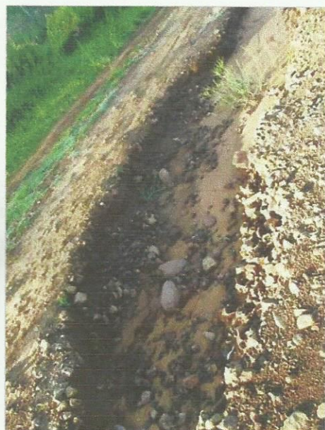
Fotos da estrada e da Ponte
