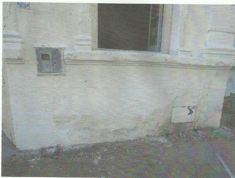
Foto 03 – Fachada Rua Conde de Porto Alegre.
