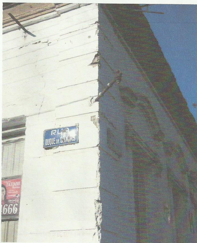
Foto 04 – Esquina Rua Conde de Porto Alegre com Rua Duque de Caxias.
