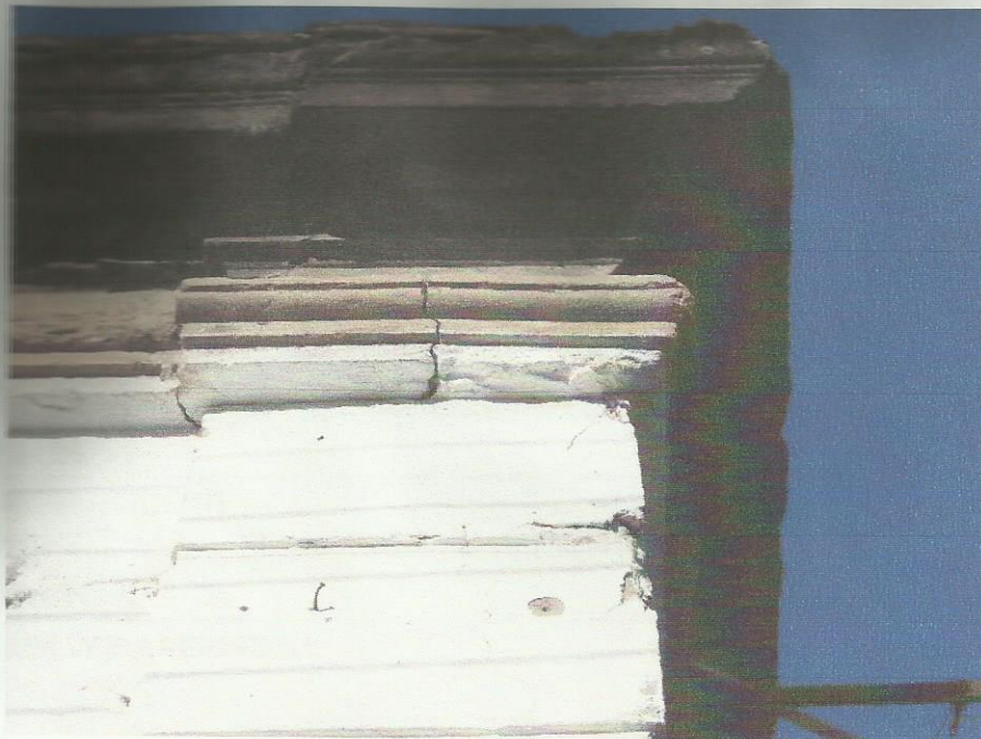
Foto 13 – Molduras da fachada.
