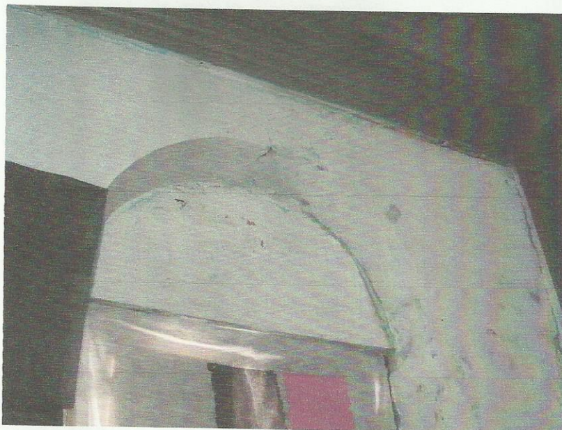
Foto 05 – Interior do prédio.
