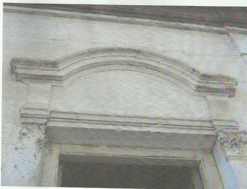
Foto 09 – Molduras na fachada.
