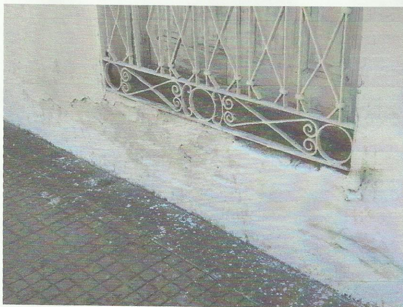
Foto 01 – Fachada Rua Conde de Porto Alegre.
