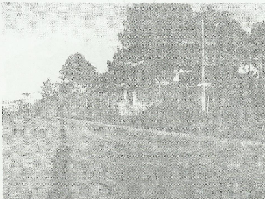
VISTA PARCIAL DA TESTADA PARA A AV. D. PEDRO II
