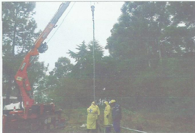
Fotos – Caminhão e equipe do Departamento de água e esgotos – DAE, durante instalação da motobomba do poço localizado no Assentamento Nova Santa Rita.
