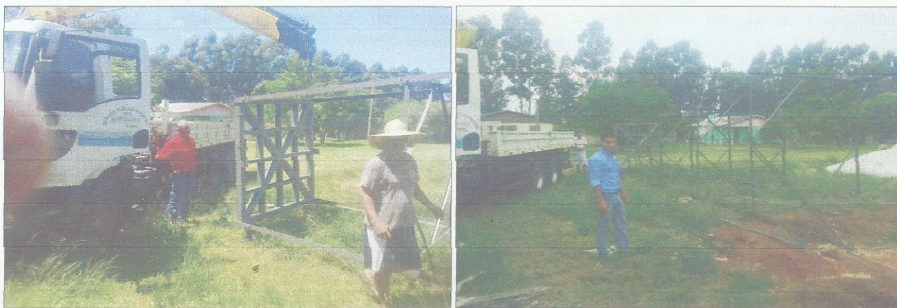
Fotos – Caminhão sendo utilizado como apoio na montagem de torre metálica para base de caixa d'água no Assentamento Nova Santa Rita.
