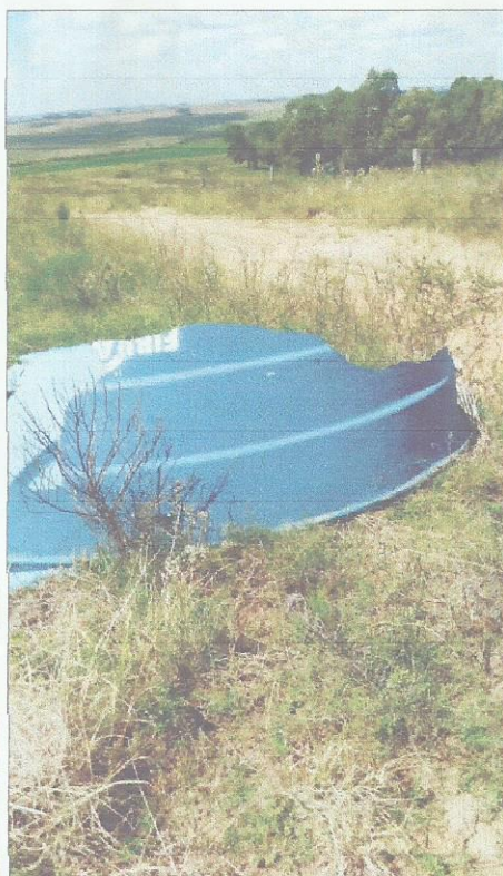
Fotos – Imagens da caixa d'água que foi instalada no Assentamento Novo Pampeiro mas que caiu da torre durante temporal. Não houve substituição, a torre metálica permanecendo instalada no local.
