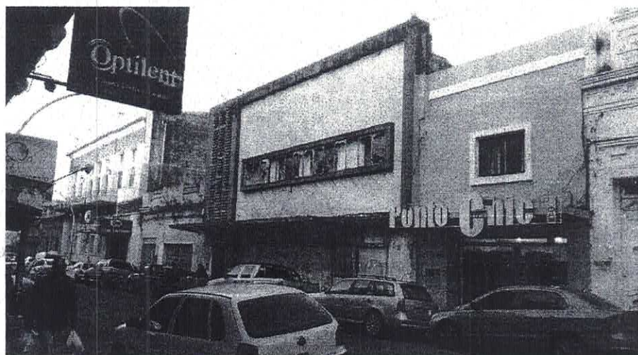
Fachada principal do prédio, Rua dos Andradas nº611, por onde se fazia o acesso do público ao Cinema Colombo
