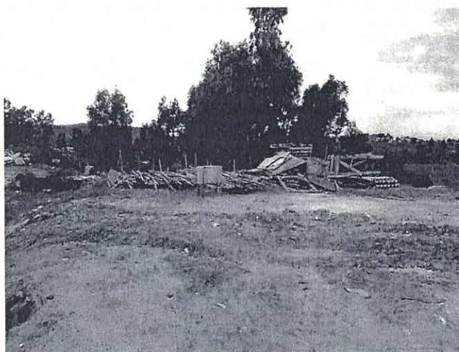
LOCAL ONDE ESTÁ SENDO REALIZADO O ARMAZENAMENTO TEMPORARIO DE RESÍDUOS DA CONSTRUÇÃO CIVIL PARA POSTERIOR DESCARTE
