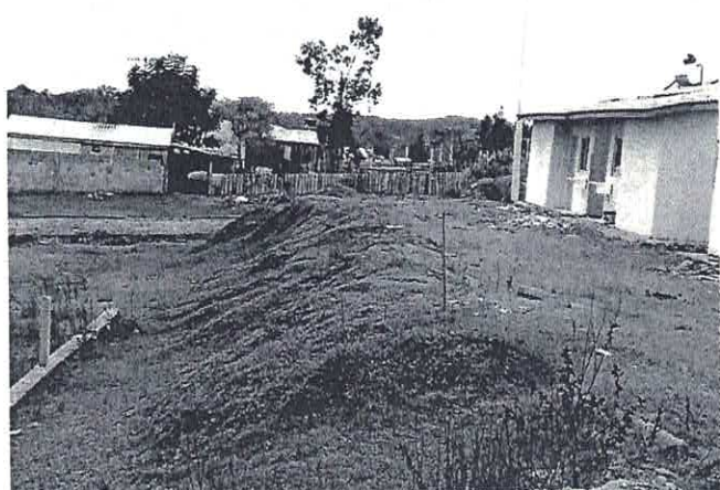
TALUDES JUNTO ÀS DIVIZAS JÁ GRAMADOS PARA EVITAR DESLIZAMENTOS DE SOLO.
