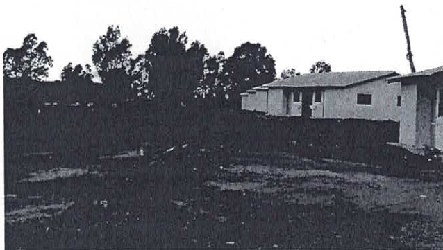
TALUDES JUNTO ÀS DIVIZAS JÁ GRAMADOS PARA EVITAR DESLIZAMENTOS DE SOLO.
