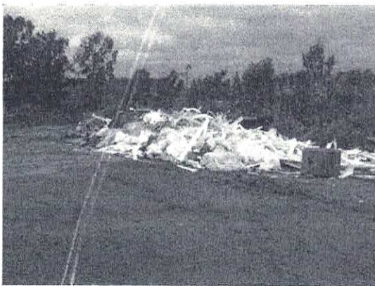
Imagem 1: Armazenamento de material em local apropriado.
