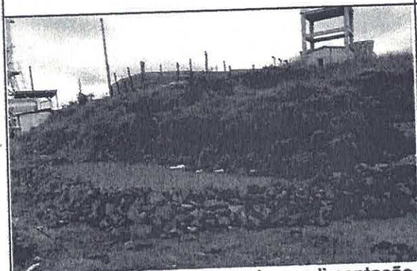
Manutenção da bacia de sedimentação localizada no Ponto 31 do Projeto de Pluvial.
