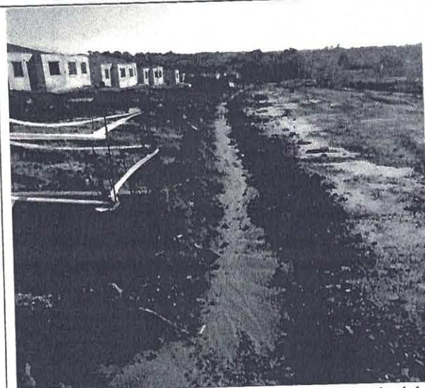
Figura 6 - Vala provisória para a drenagem do pluvial na Rua N.
