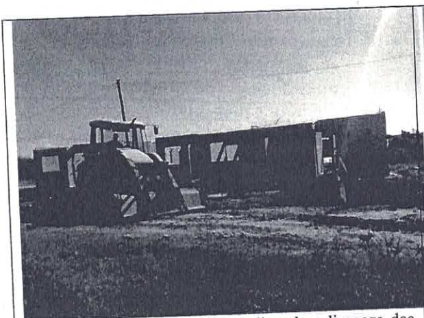
Figura 8 - Retroescavadeira realizando a limpeza das quadras.
