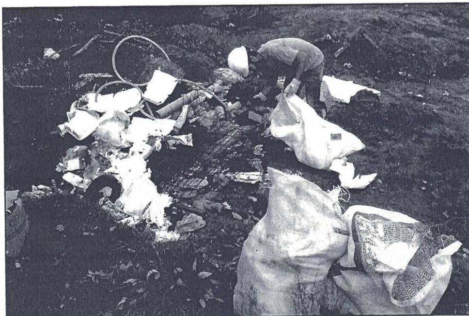
Figura 2 - Limpeza da área
