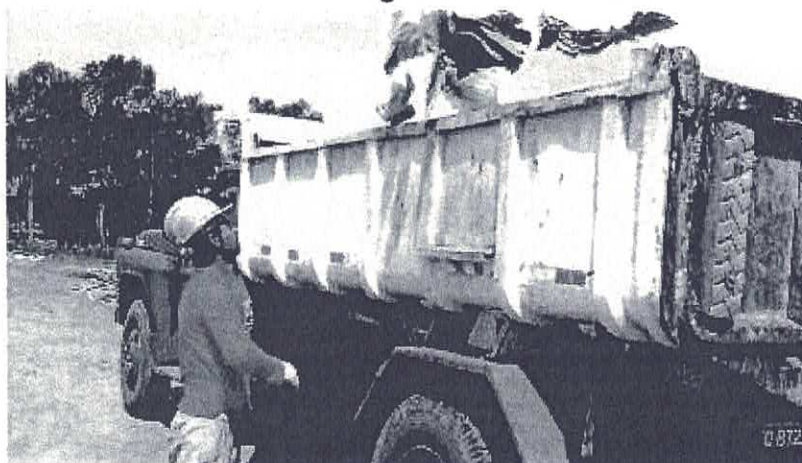
Carregamento dos resíduos em caminhão manualmente para descarte.
