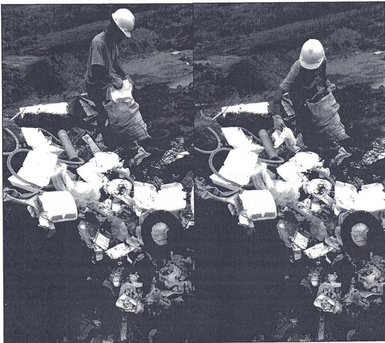
Figura 1 - Remoção dos resíduos.
