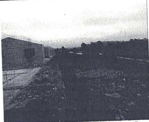
Execução da vala objeto da notificação nº 3420.
