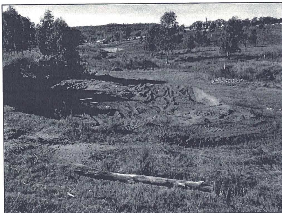
Figura 3 - Área após a terraplanagem
