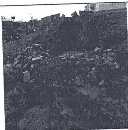
Execução da vala objeto da notificação nº 3420. Foi enrocada a saída da vala, porém na vistoria do dia 08/06, foi solicitado o reforço do enrocamento na saída e na parte superior da vala.
