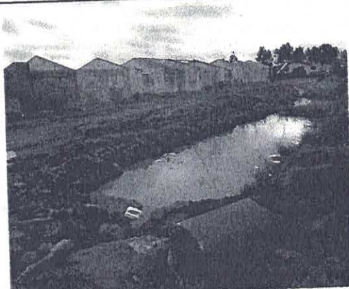
Manutenção da bacia de sedimentação localizada no Ponto 31 do Projeto de Pluvial. Na vistoria do dia 08/06, foi solicitado o reforço do enrocamento no entorno da bacia.
