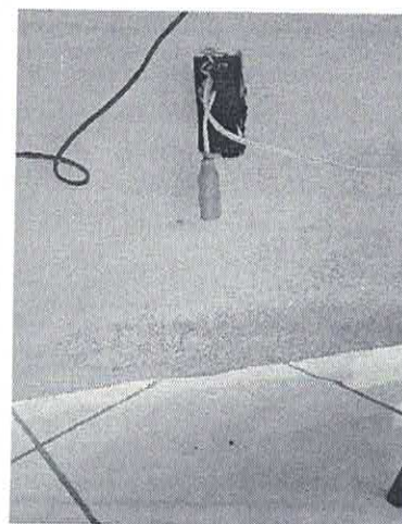
Abertura tomada inadequada/derivação
