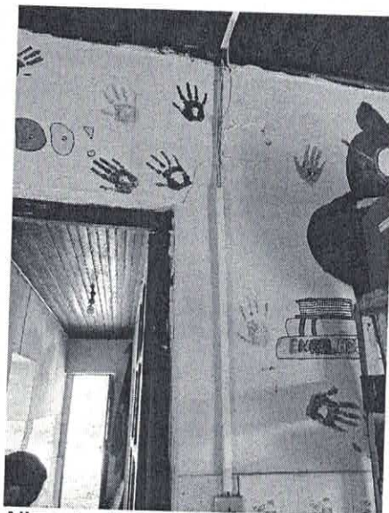
Alimentação de tomadas com cabo paralelo
