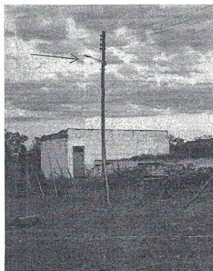
Iluminação externa, Vapor de Sódio
