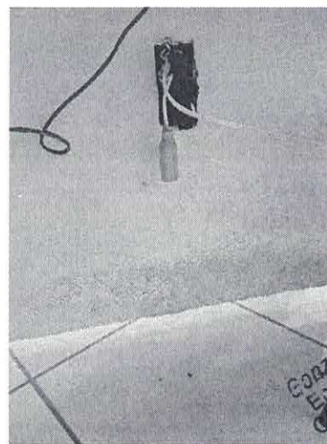
Abertura tomada inadequada/derivação
