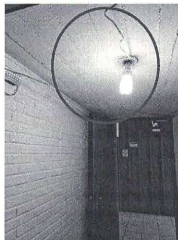
Iluminação corredor/cabo exposto
