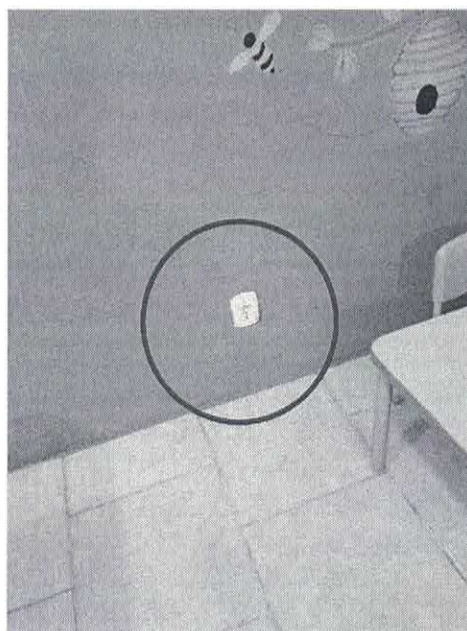
Tomada baixa sem proteção
