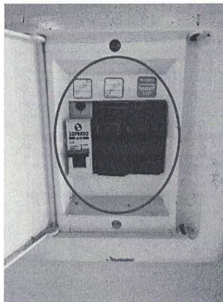
Quadro com disjuntores nema e din
