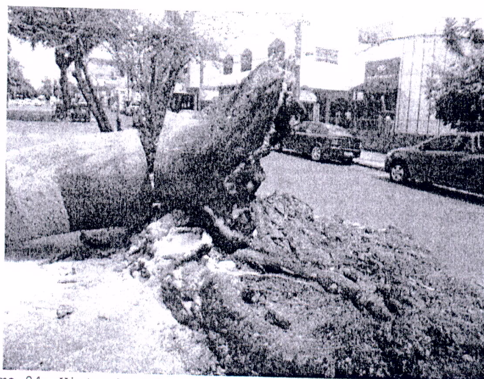
Figura 04: Vista da falta de sustentação do vegetal, 24/12/2022.
