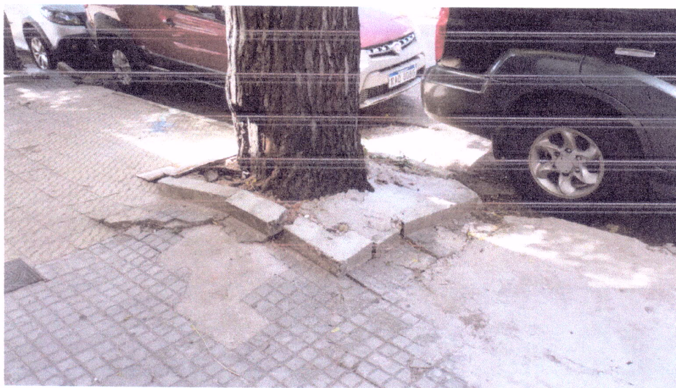
Imagem 1: Vista de elevação da calçada pelas raízes e cicatriz no colo do vegetal.
