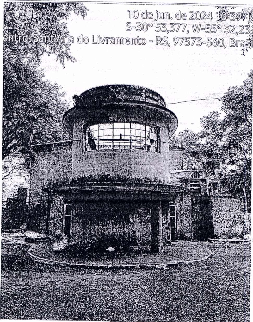
Os banheiros descaracterizaram o projeto de arquitetura original
