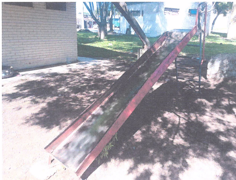
Foto 01 - Tirada em janeiro de 2025. Escorregador da pracinha da Caixa d'Água. Equipamento enferrujado e pintura desgastada.
