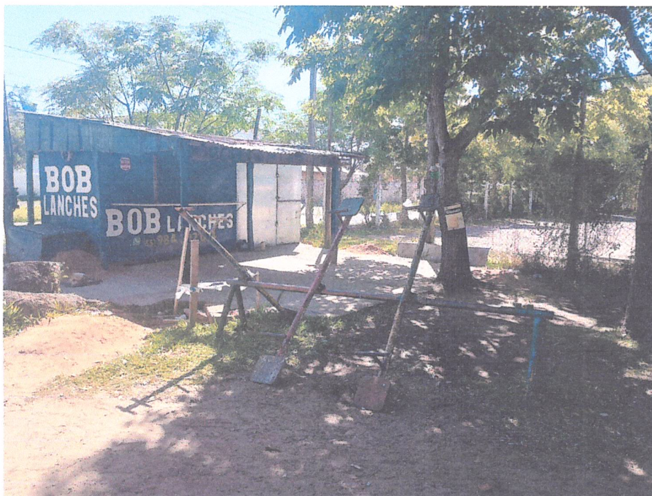
Foto 08 - Gangorra da pracinha da Caixa d'Água. A estrutura está avariada e frouxa, não apresentando condições de segurança para uso infantil.
