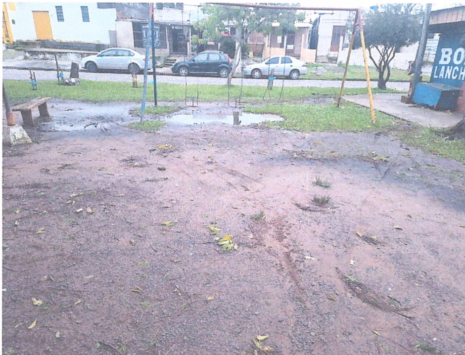
Foto 07 - Tirada em junho de 2025. Segue sem manutenção ou melhorias.
