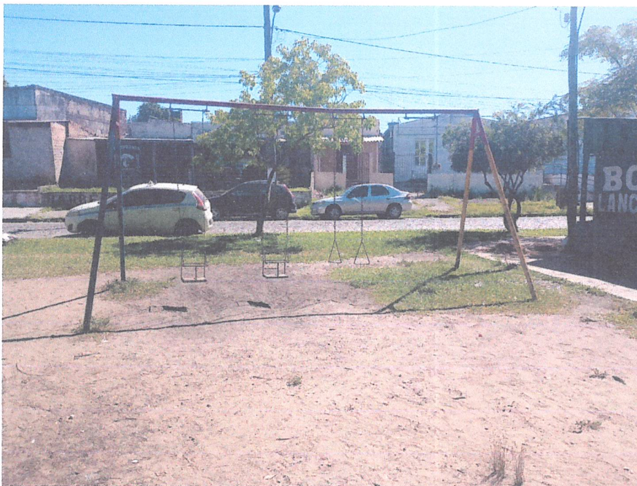
Foto 06 - Tirada em janeiro de 2025. Estrutura de balanço na pracinha da Caixa d'Água. Equipamento com dois assentos de balanço pendurados por correntes enferrujadas. A pintura da estrutura está desgastada e o solo ao redor está exposto e sem manutenção adequada.
